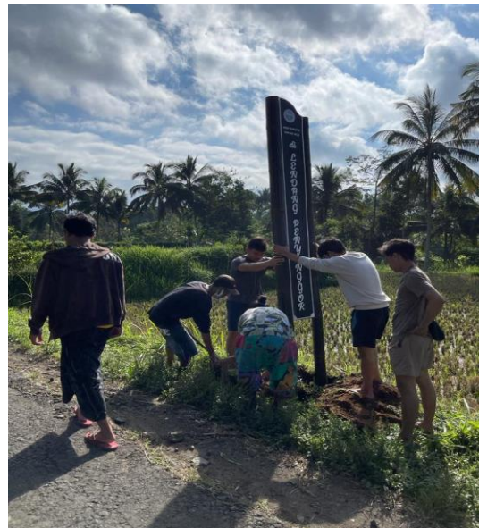
Gambar 5. Proses Pemasangan Gapura di Jalan Perbatasan antara Dusun Lendang Penyongkok dengan Dusun Otak Bangket
