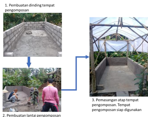
Gambar 2. Proses pembuatan rumah kompos
